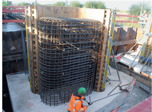
Die Bauarbeiten beeindruckten.
